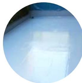
Teras Polyurea Uygulaması
